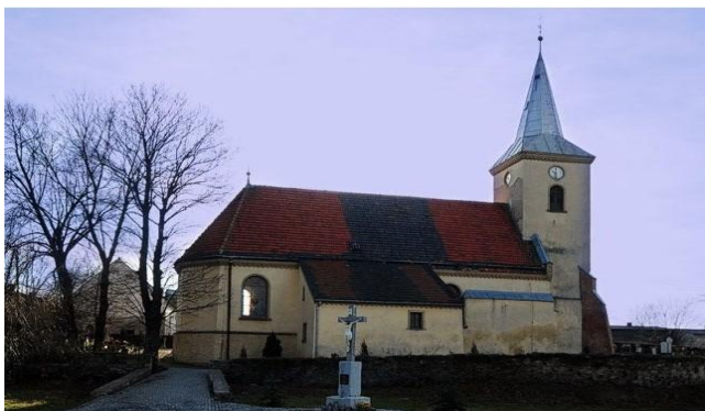
Fot. 33. Kościół filialny pw. św. Anny w Marcinowicach
