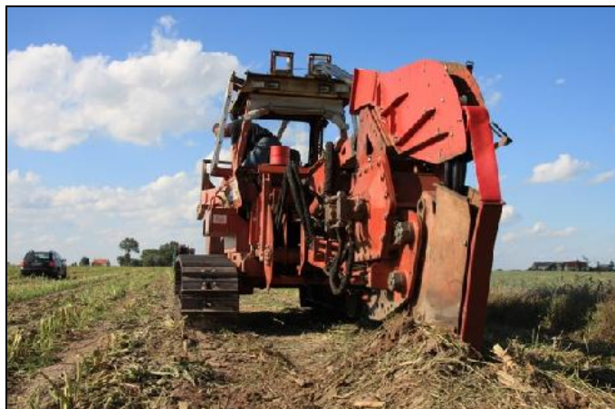
Rycina 15. Sprzęt wykorzystywany do układania kabli metodą plużenia (źródło: http://thomsen.pl )
